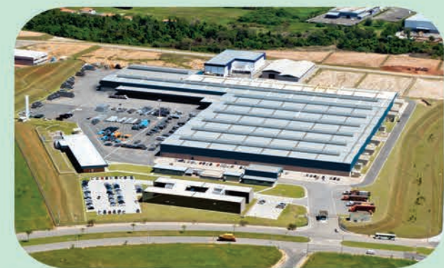
Vista aérea da fábrica em Jundiaí - SP
